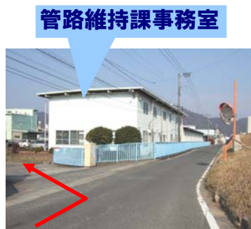
⑥入って右側の建物が管路維持課 の事務室, 奥の右側の建物が水 道技術研修センターになります。
